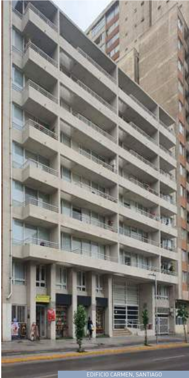
EDIFICIO CARMEN, SANTIAGO
