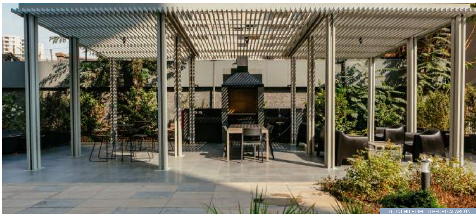
QUINCHO EDIFICIO PEDRO ALARCÓN
