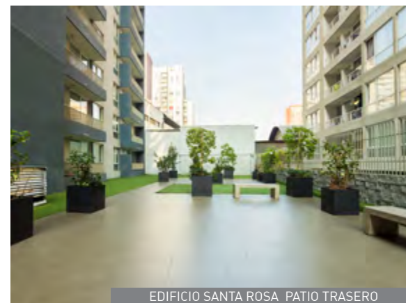
EDIFICIO SANTA ROSA PATIO TRASERO
